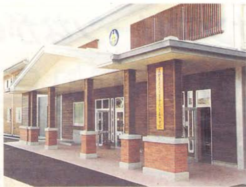
新校舎の昇降口
