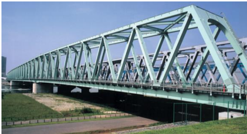
図1：トラス構造を利用した鉄橋
